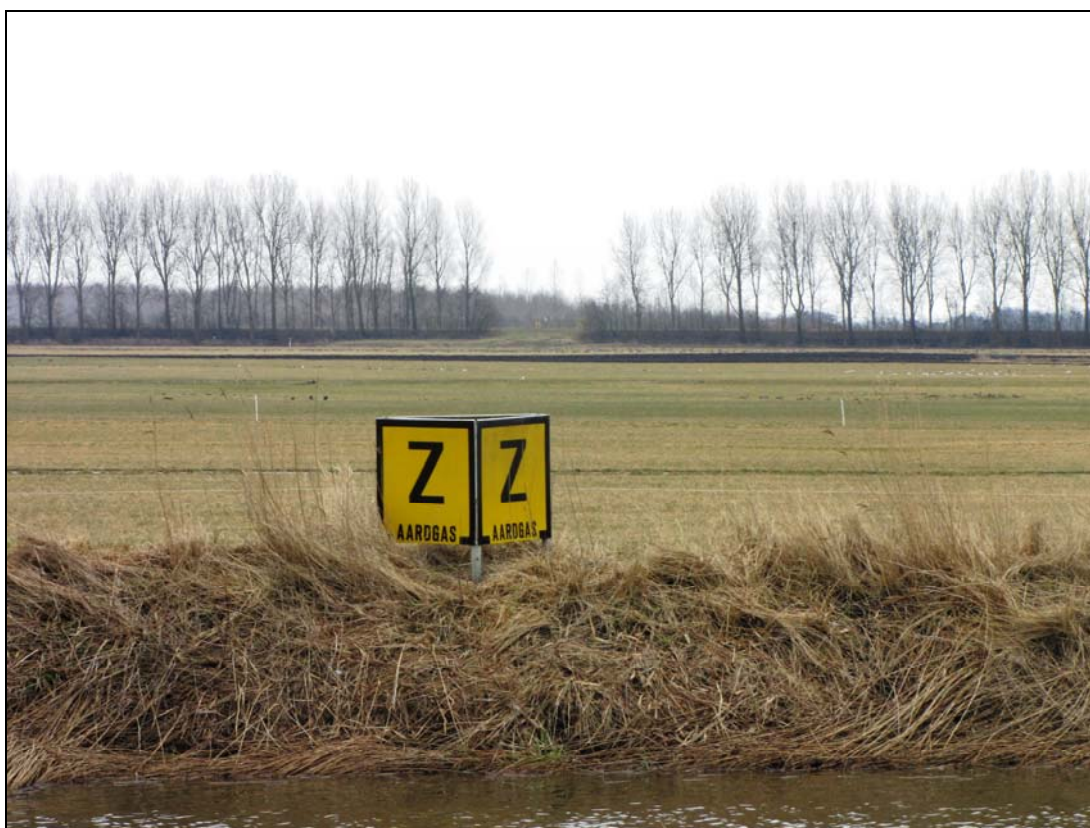
Figuur 2. Ondergrondse aardgasleiding ten zuiden van Ten Boer
